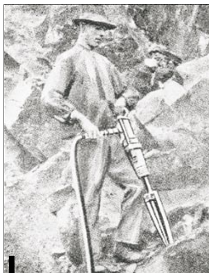
Fot. 2. Pneumatyczna kliniarka do kamienia (Breachkeil) – B&S Saltzbach
